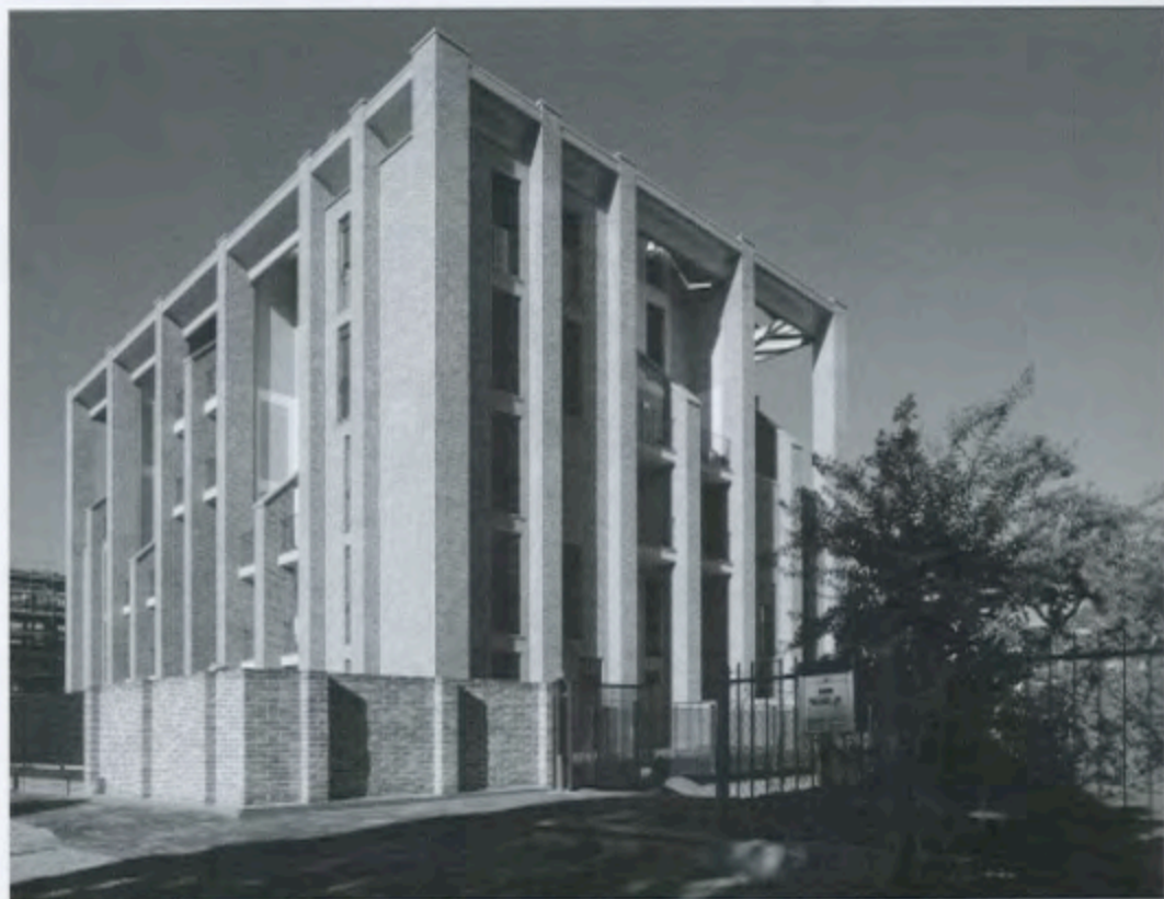
8/ Isotta Cortesi, Edificio residenziale a Parma, 2003-2006.
